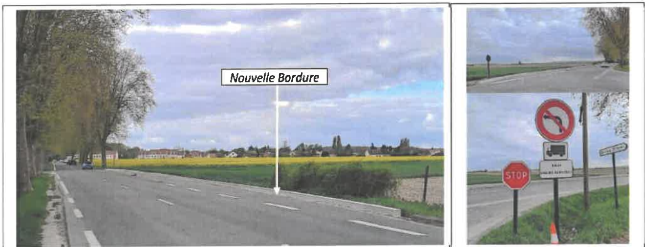
Vue de la nouvelle bordure de délimitation du tourne-à-gauche, rénovation des marquages au sol et panneau de sortie de site interdisant de tourner directement à gauche pour les Poids Lourds (photo du 24/04/24).
