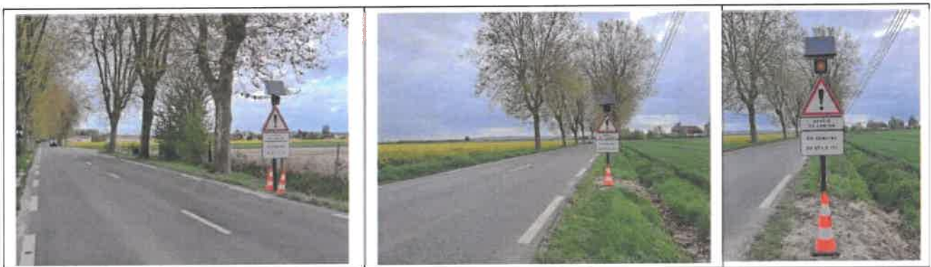
Vue des deux panneaux de signalisation mono-flash avec batterie solaire sur la RD 909 (photo du 24/04/24)
